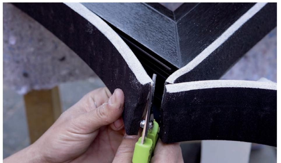
Die Bandstücke werden direkt von der Rolle zugeschnitten und auf den Blendrahmen geklebt, so dass die hellgrau gepulverte Seite zum Innenraum zeigt.
