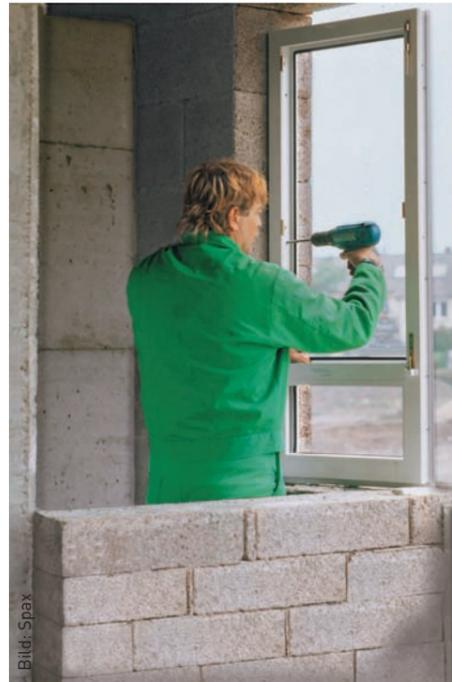
Der Spax-Rahmenanker befestigt Fenster- und Türrahmen aus beliebigen Werkstoffen in sämtlichen Steinmaterialien und Holz.
